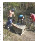
Chantier pierre sèche sur la réserve de Mancy
