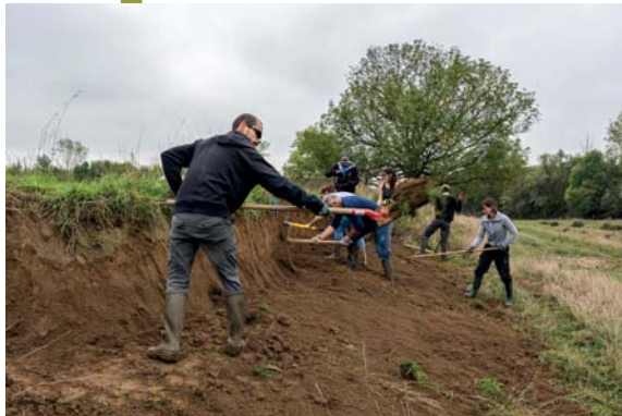
Chantier de création de berges pour le guépier d'Europe Crédit photo - Hugo Barré-Chaubet
