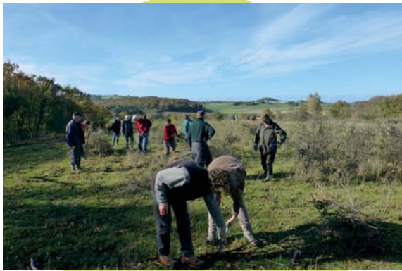
chantier réouverture d'une pelouse
